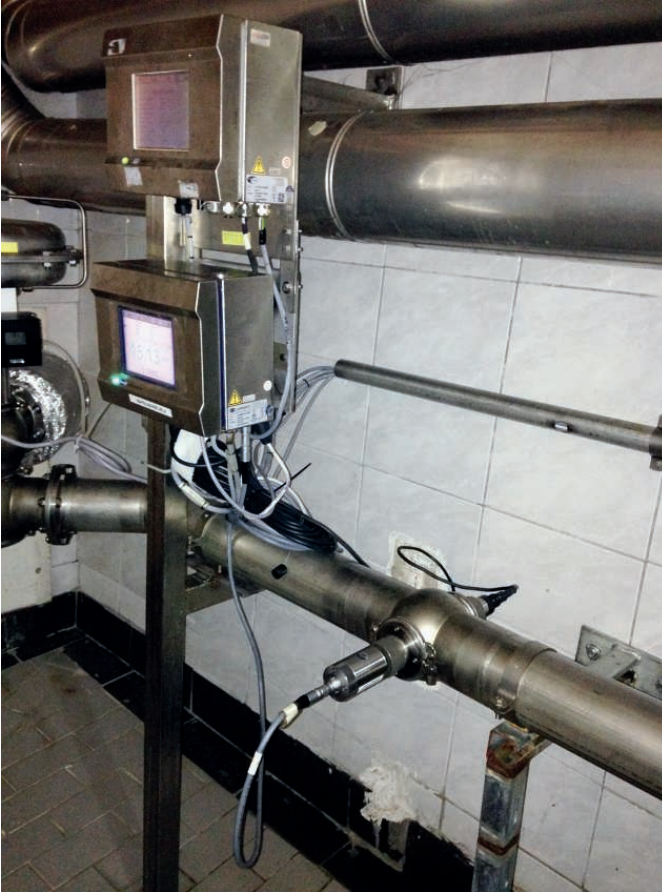
Şekil 2. Hach 410 Kontrol Üniteleri – tipik kurulum
