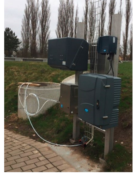
Şekil 2: Hach Amtax sc Amonyum Analizörü, Nitratax sc Nitrat Sensörü ve SC1000 Kontrol Ünitesi Prob Modülü.
